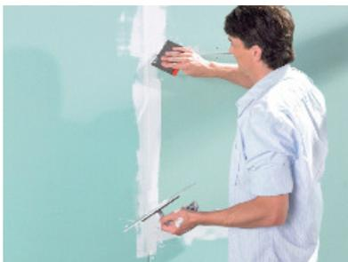
Verspachteln Sie die Fuge nach den Angaben des Platten- bzw. Spachtelherstellers. Wie empfohlen die Verwendung von Fugendeckstreifen.
